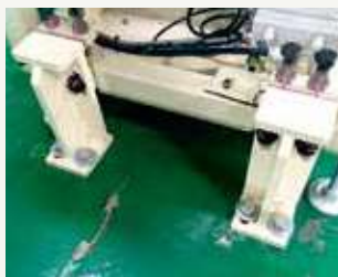
大型製造機器の固定
