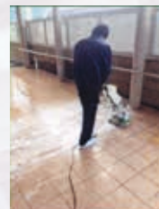
滑り止め工事
