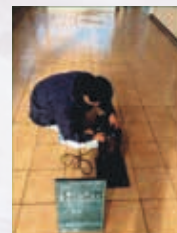
施工後抵抗値測定
