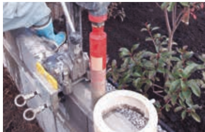
フェンス下穴穿孔
