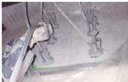
無収縮モルタル注入
