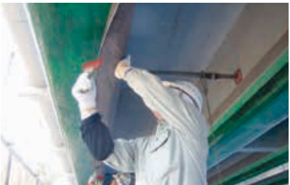
シート貼り工
