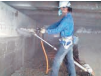
削岩機での削孔
