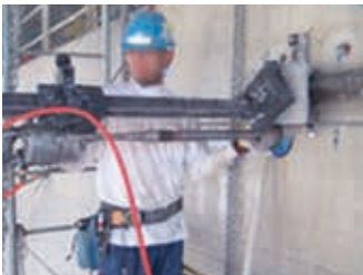
橋梁補強用アンカー設置工事
