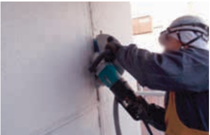
ハンドカッターによる切断
