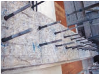
アンカー打設後
