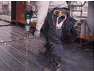
デッキインサート工事
