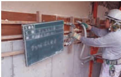
無収縮モルタル圧入
