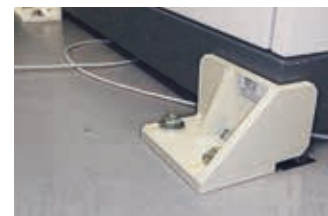
製造設備施工
