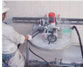
ウォールソーによる水平切断
