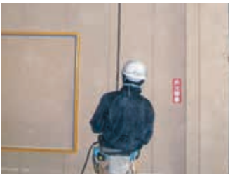
天井アンカー工事
