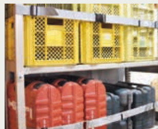
倉庫でのラック固定・落下防止
