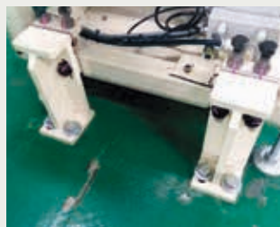
大型製造機器の固定
