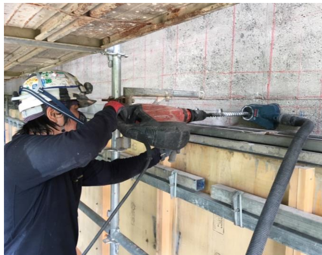
あと施工アンカー工事
